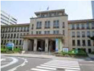
昭和12年から使われている静岡県庁本館。県議会が入っている。
