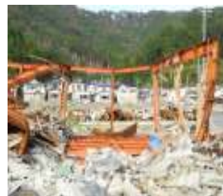
山田町では、昔からの言い伝えを守り、高台に移転し被災しなかった集落(奥側)「津波てんでんこ」も言い伝え
